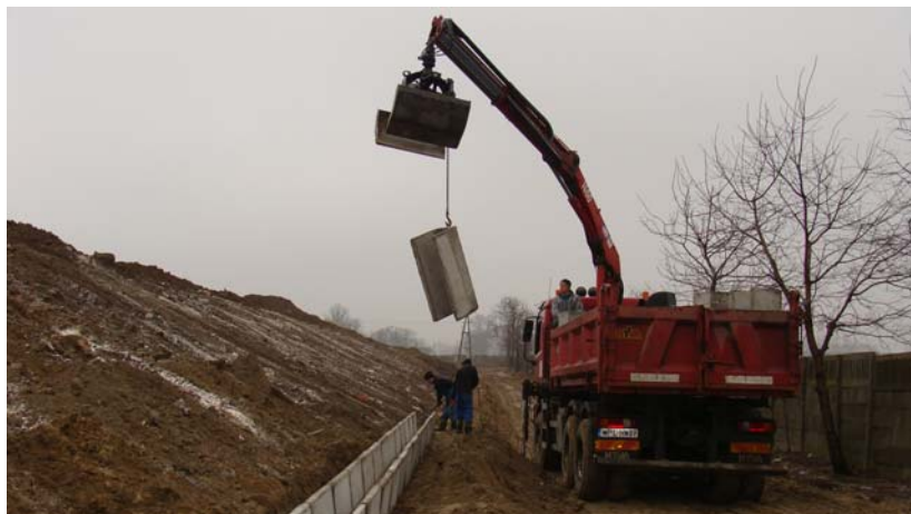
W trakcie realizacji
