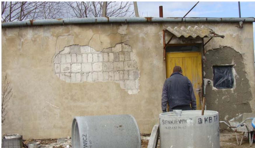
Budynki przed remontem
