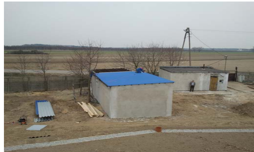
Budynki w trakcie remontu
