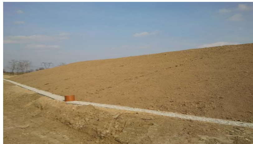
Po wykonaniu prac
