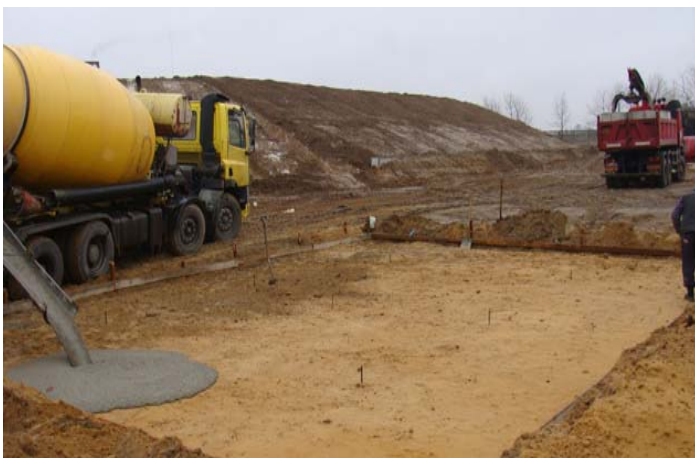
W trakcie realizacji
